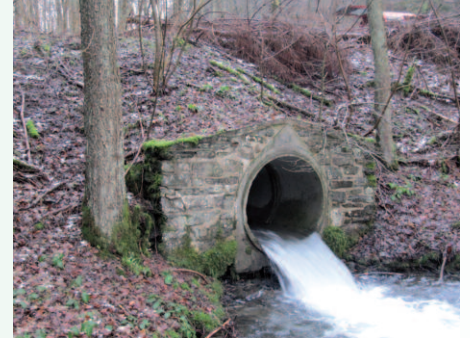
Verrohrung am Tiefenbach im Schutzgebiet „Kalltal und Nebentäler“
